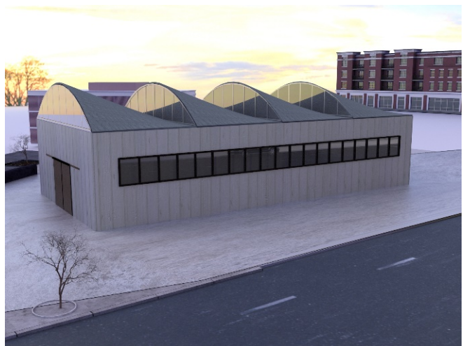
Slika 4. Testerasti krov sa ravnim žlebom konoida.
