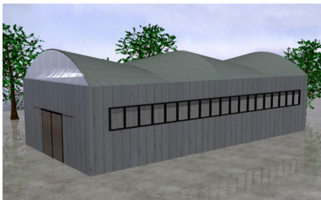
Slika 6. Testerasti krov sa naspramnim konoidima.
