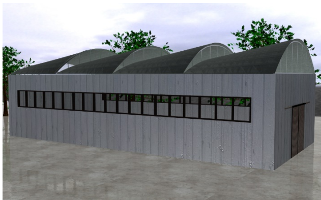
Slika 5. Testerasti krov sa zakrivljenim žlebom konoida.
