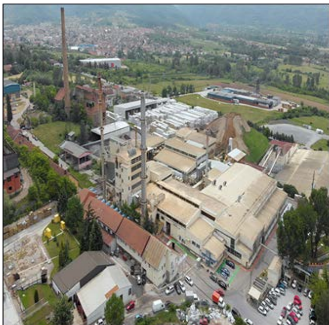
Slika 1. Fabrika "KNAUF INSULATION" Surdulica.
